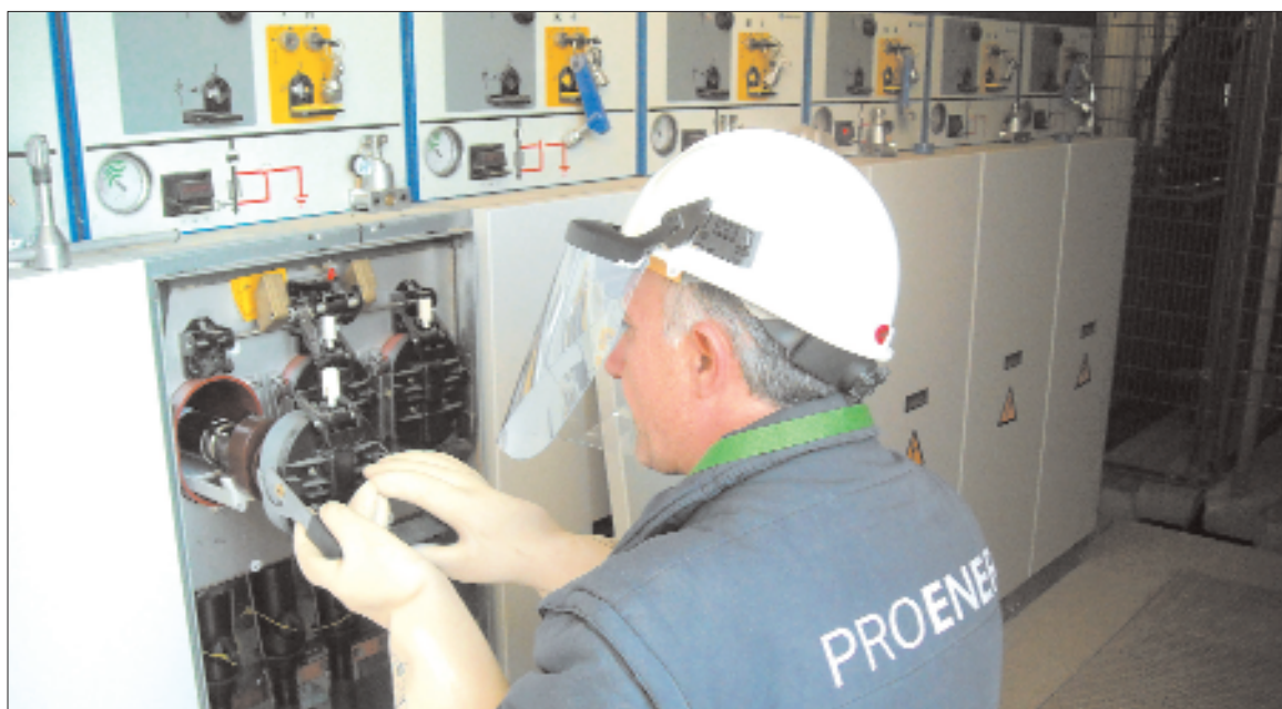
Un trabajador de Proener realiza trabajos de mantenimiento en equipos automáticos
